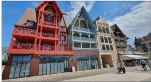
Le groupe EIFFAGE a réalisé les travaux de la presque île de Touques.
