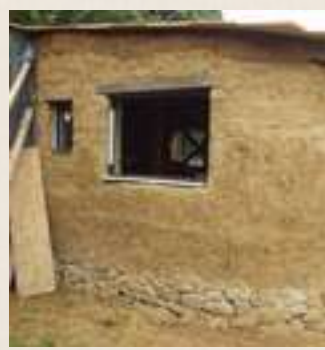
Construction en terre
