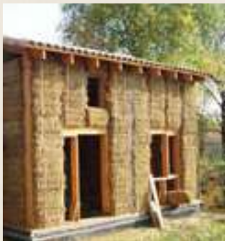
Construction en paille et bois
