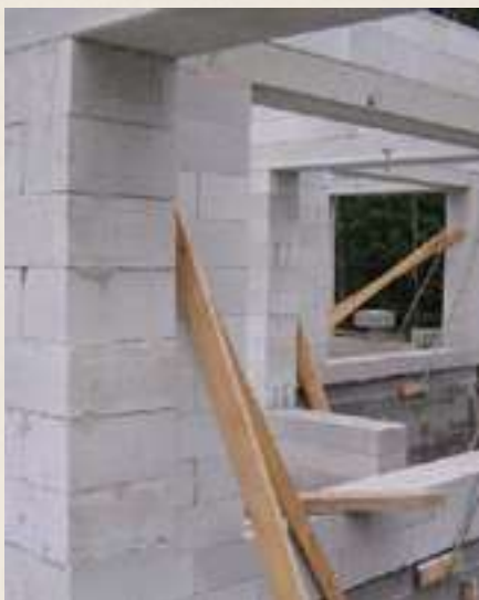
Construction en béton cellulaire
