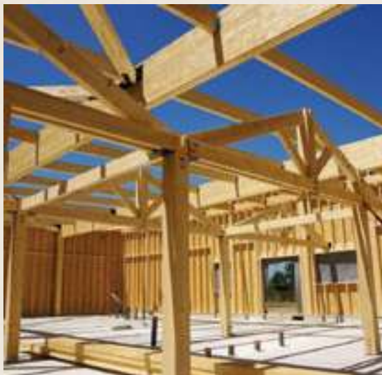
Construction en bois
